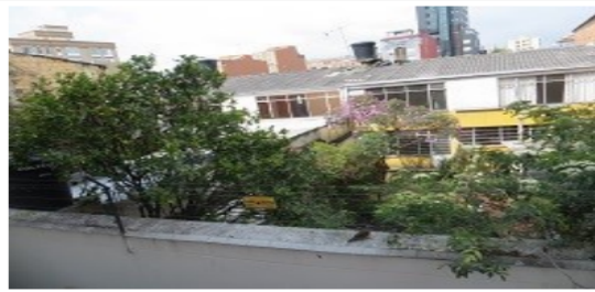
Foto 6.- Vista general antes
